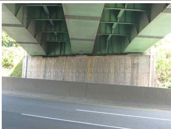
교대 A1 전경
