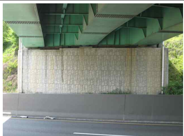
교대 A2 전경
